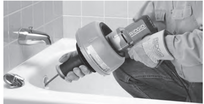
Şekil 9 - Spiral Kanal Hattına İtin
