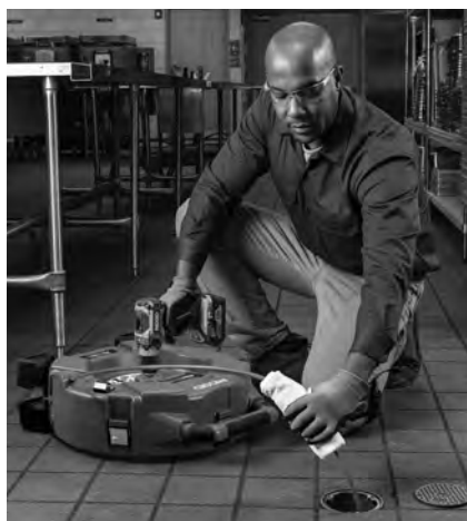
図 13 - ケーブルシースへの潤滑油の塗布
