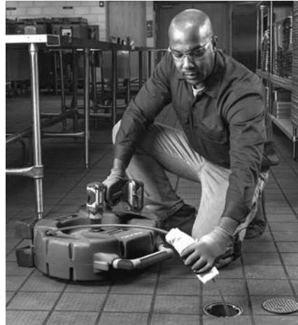
Рис. 13 - Нанесение смазки на оболочку троса
