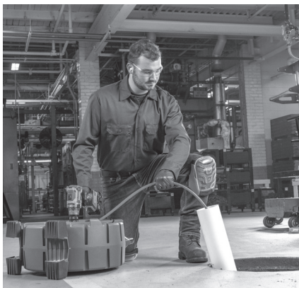
図5 - ケーブル引出口から管の入り口までの距離を1m以内に短縮している例
