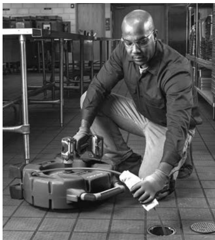
Figura 13 – Aplicar lubrificante ao revestimento do cabo
