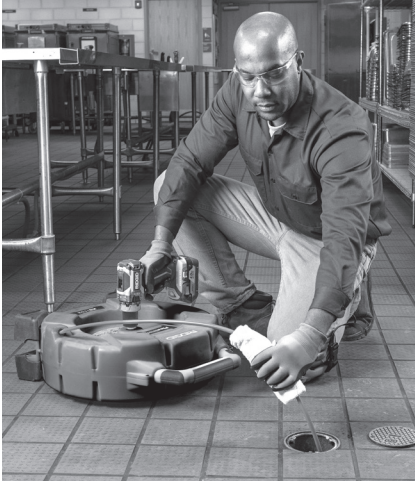
図 13 - ケーブルシースへの潤滑油の塗布
