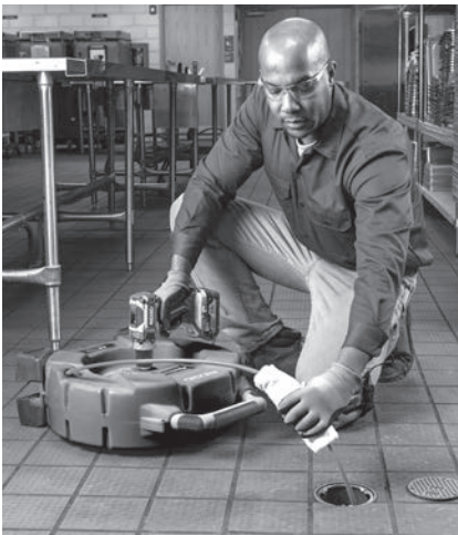
Figura 13 – Aplicación de lubricante sobre la vaina del cable
