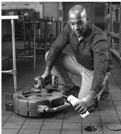
Εικόνα 13 – Εφαρμογή λιπαντικού στο περίβλημα σπирάλ
