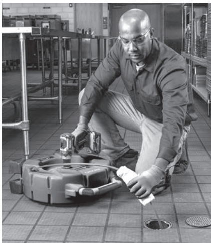
Figure 13 – Application de lubrifiant sur la gaine du câble
