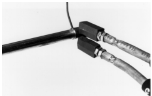
Figure 7 – Soudage avec les embouts au carbone en contact avec le raccord
