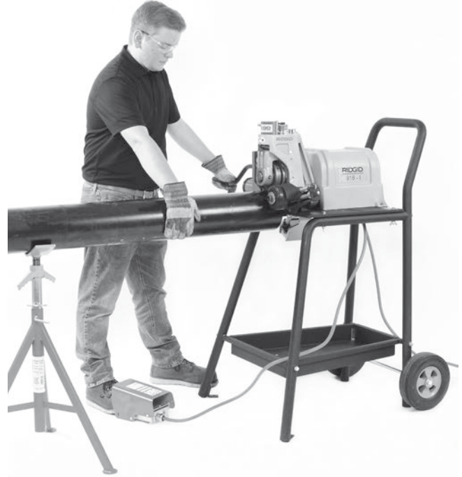
Şekil 17 - Boruya Basınç Uygulanması
