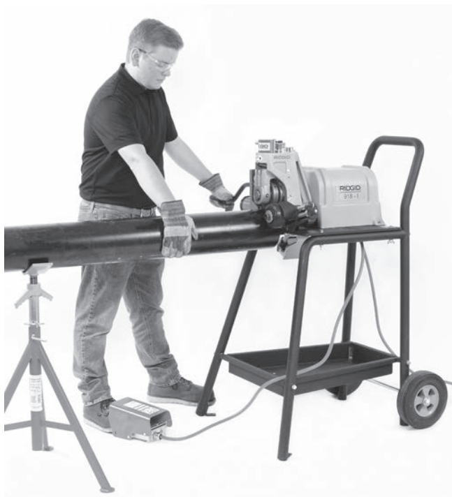
Figura 17 – Aplicación de presión sobre el tubo
