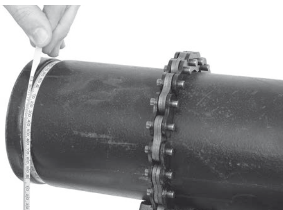
Figura 18 – Verificar o diâmetro da ranhura com uma fita de diâmetro
