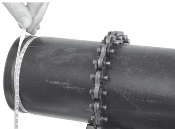
Figura 18 - Controllo del diametro di scanalatura con l'apposito nastro
