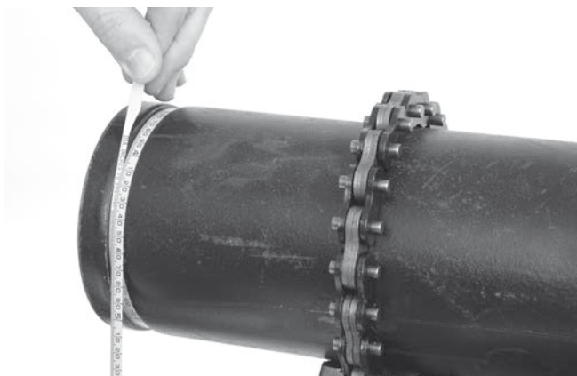
Figura 18 – Verificarea diametrului canelurii cu o ruletă pentru diametru
