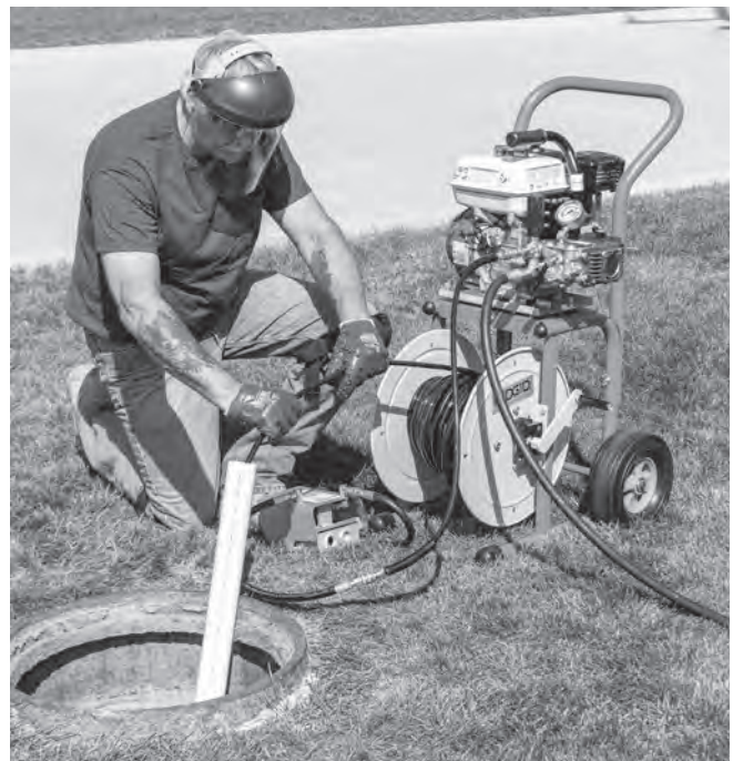
Figura 11 – Uso de un tubo guía para introducir la manguera hasta el lugar que va a limpiar
