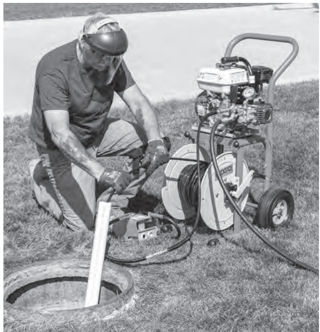
Figure 11 – Prolongement de l'accès jusqu'au point de curage.
