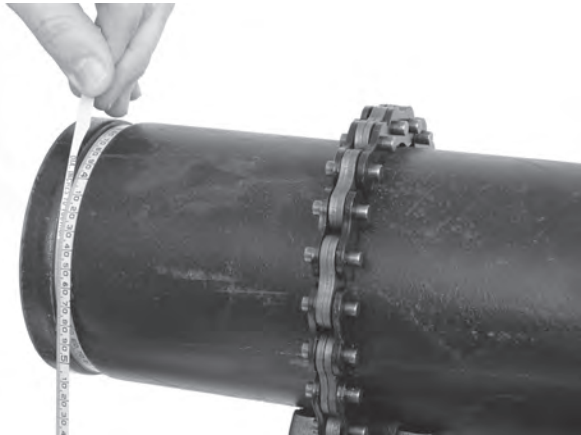
Abbildung 17 - Prüfen des Nutdurchmessers mit einem Durchmesserband
