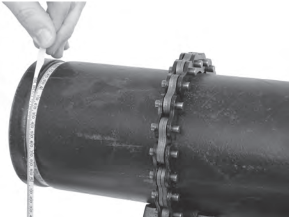
Figure 17 – Vérification du diamètre en fond de rainure à l'aide d'un ruban
