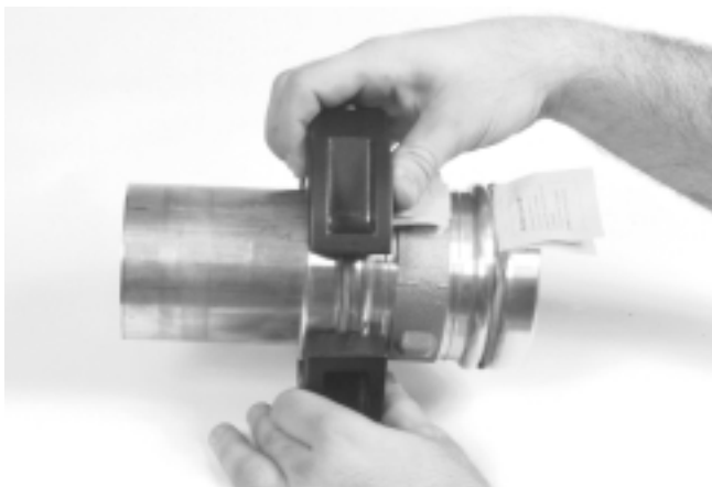
Figura 10 – Instalación del aro sobre el acoplamiento
