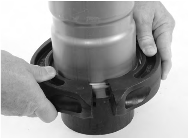
Figure 10 – Engagement de la bague de sertissage sur le raccord
