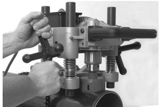
Рис. 11 - Работа на станке для вырезания отверстий
