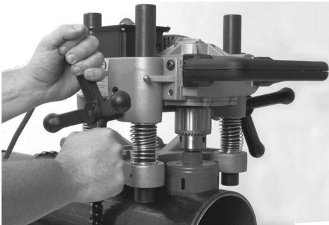
Εικόνα 11 – Χειρισμός του μηχανήματος διάτρησης σωλήνων
