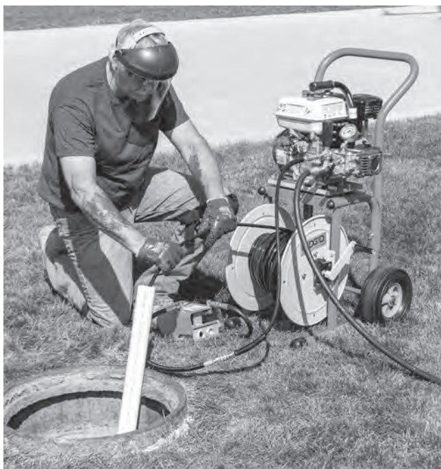
Figure 11 – Prolongement de l'accès jusqu'au point de curage.
