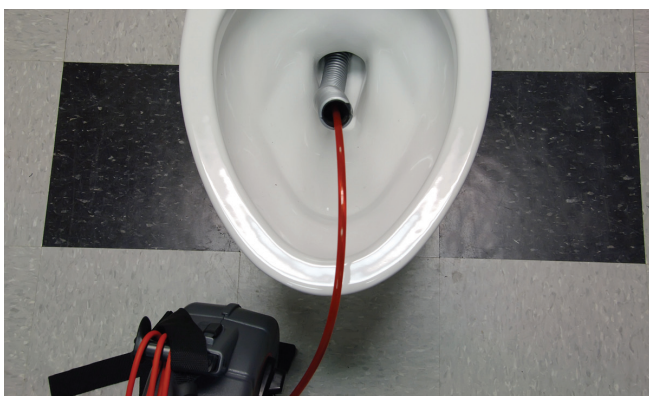
Figura 23 – Utilizando un tubo de guía flexible
