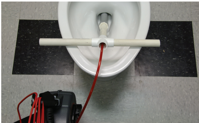
Figura 22 – Utilizando un tubo de guía de PVC
