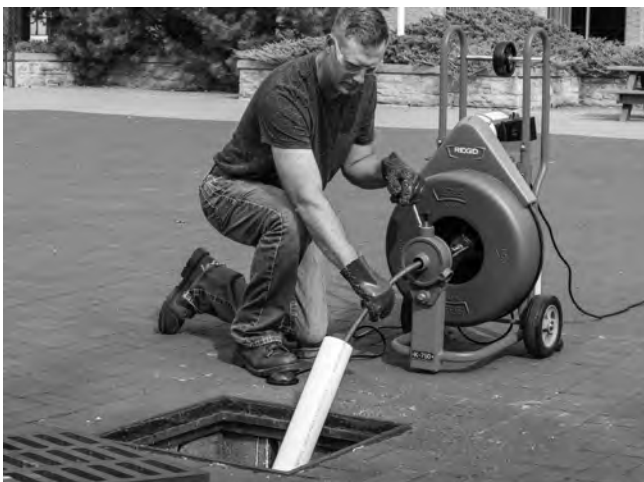
Figura 10 – Ejemplo de cómo extender el desagüe para que el acceso quede a menos de 3 pies de la salida del cable
