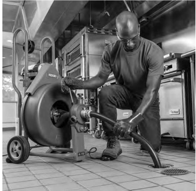
Figure 15 – Utilisation du dégorgeoir avec guide-câble
