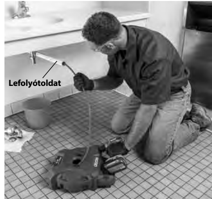
5. ábra – Példa a lefolyócső hozzáférési pontjának meghosszabbítására, hogy az 3' távon belül legyen a gép kábelkimenetétől
