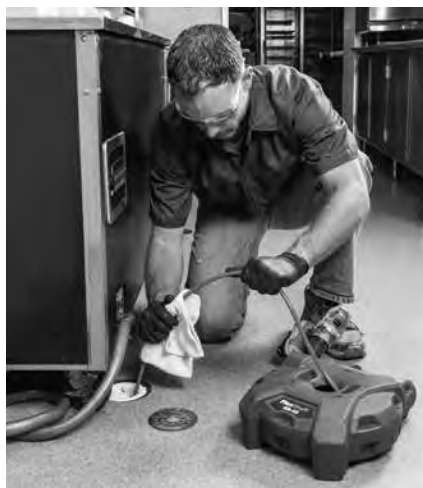
Slika 15 – Nanošenje maziva na oblogu sajle
