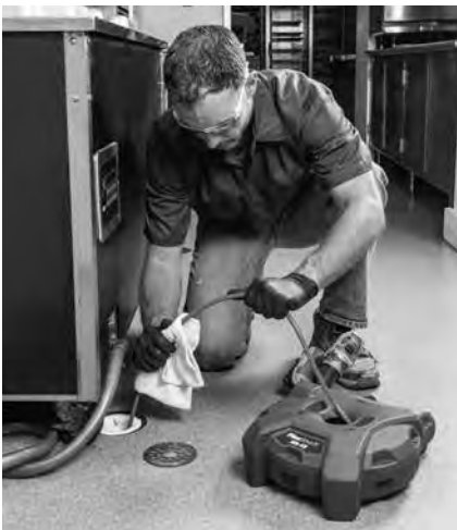
Abbildung 15 – Auftragen von Schmiermittel auf die Spiralenummantelung
