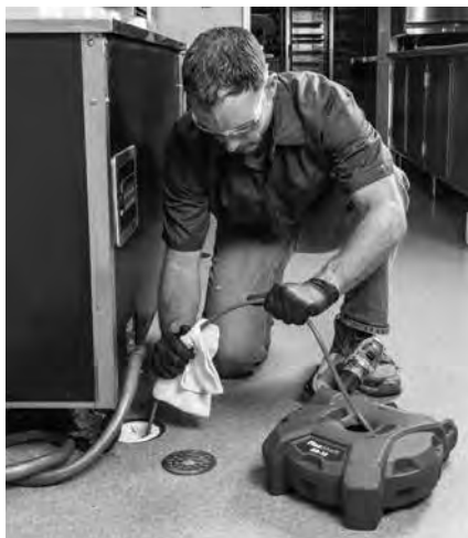
Figuur 15 – Smeermiddel aanbrengen op de veermantel
