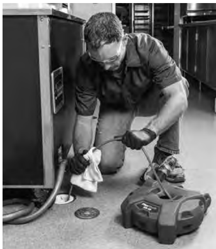
Figura 15 – Aplicar lubrificante ao revestimento do cabo
