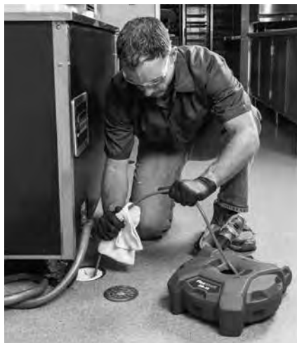
Рис. 15 - Нанесение смазки на оболочку троса
