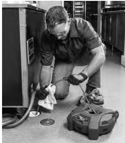
Slika 15 – Nanošenje maziva na izolaciju sajle
