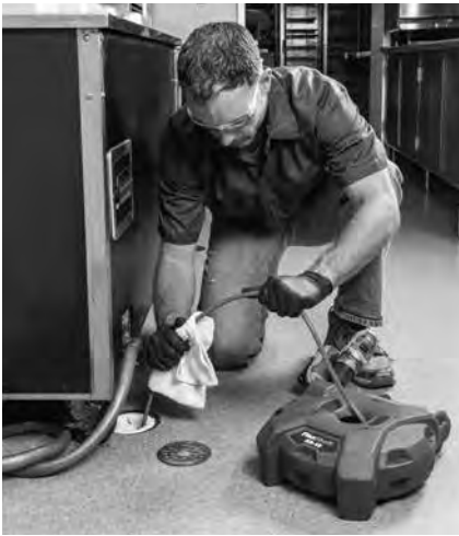
Figura 15 – Ungerea manșonului cablului
