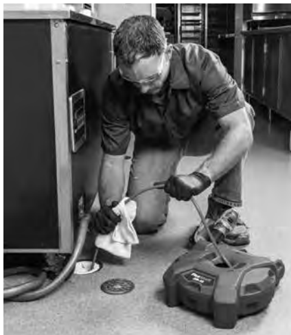
Figur 15 – Påføring af smøremiddel på spiralkappen
