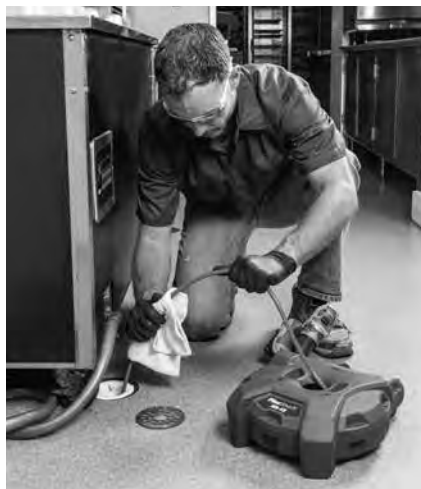
Figura 15 – Aplicación de lubricante sobre la vaina del cable
