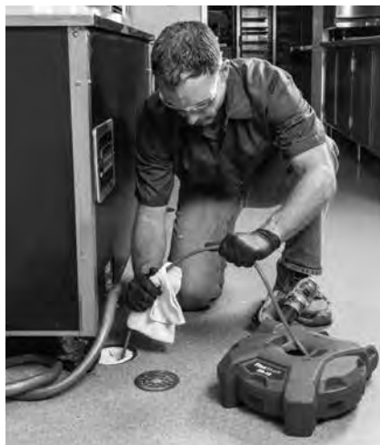
Фигура 15 – Прилагане на смазка към кабелната облицовка
