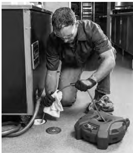
Obrázok 15 – Nanášanie maziva na plášť kábla
