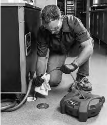
15. Ábra – Kenőanyag felvitele a kábelköpenyre
