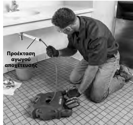
Εικόνα 5 – Παράδειγμα προέκτασης του ανοίγματος πρόσβασης στην αποχέτευση σε απόσταση εντός 3' από την έξοδο του σπιδάλ στο μηχανήμα
