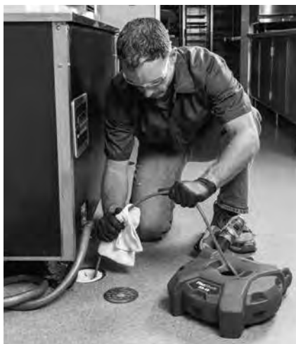
Figur 15 - Påføring av smøremiddel på kabelmantelen
