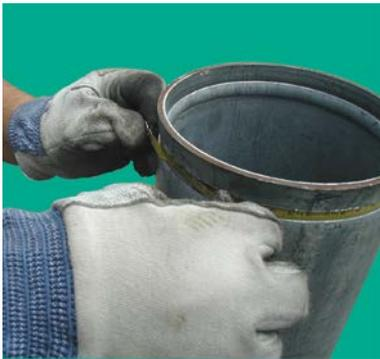
付属の周長ゲージ(巻尺)で溝周長のチェックを行います。また管端がフレアになっているときは、管端部の直径もチェックして下さい。
