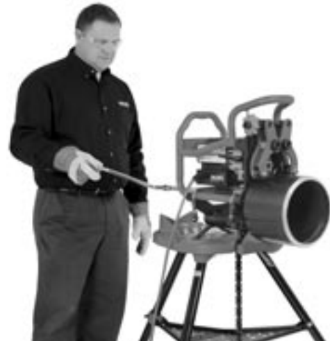
Figure 20C – Biseautage en cours (machine fixe/tuyau mobile)
