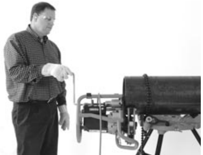
Figure 20B – Biseautage en cours (pièce fixe/machine mobile)
