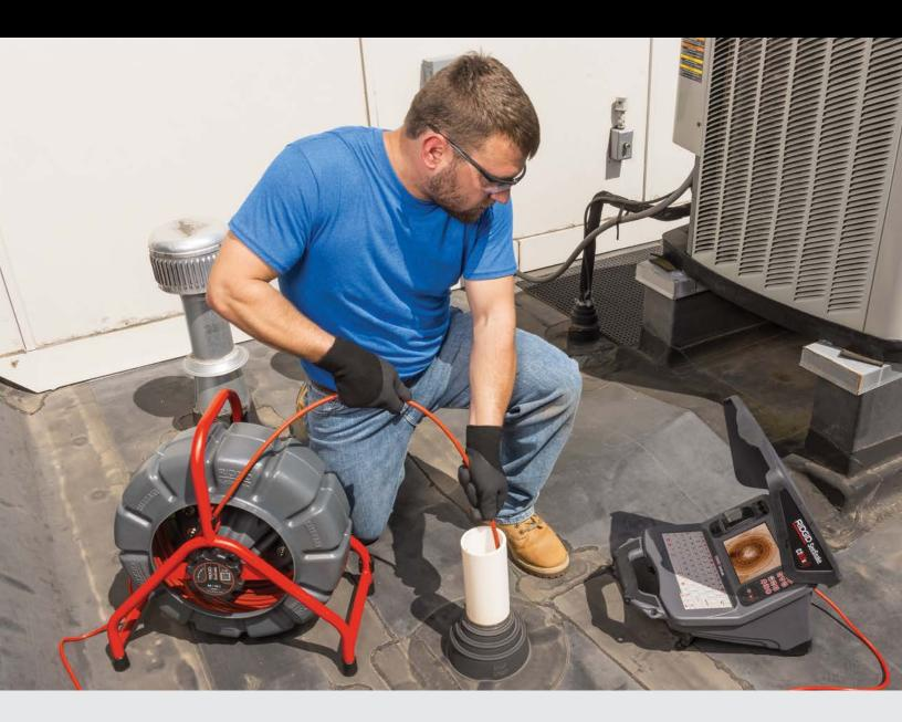
Le cadre diminutif du SeeSnake® Mini renferme la robustesse et la versatilité qui en font une caméra à tout faire exceptionnelle pour une variété de sections de tuyau. La nouvelle technologie TruSense comprend à la fois un capteur d'image à portée dynamique élevée (HDR) ainsi qu'un inclinomètre TiltSense™ sur les moniteurs à connectivité Wi-Fi de la série SeeSnake CSx.
