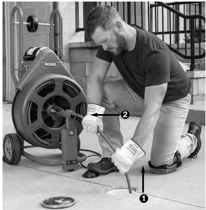
Figure 13 – (1) Retrait du câble et (2) son rembobinage dans le tambour
