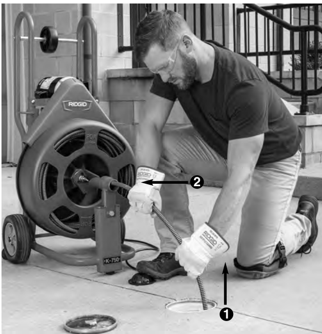
Figura 13 – El operario está (1) jalando el cable y (2) metiéndolo en el tambor
