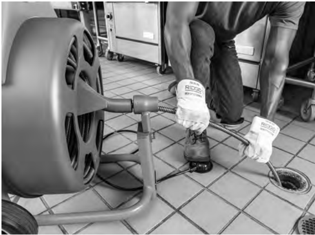
Figura 12 – Introducción del cable en el desagüe
