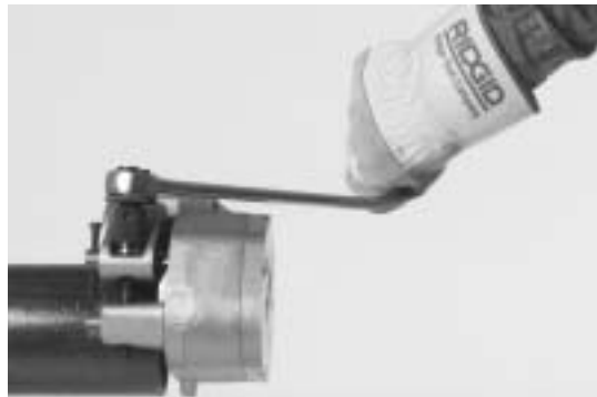
図 6 ラチェットハンドルの取付け
