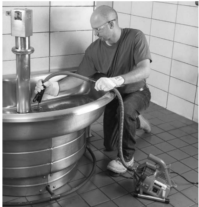
Figur 11 – Trekke ut kabelen
