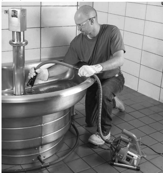
Slika 11 – Izvlačenje sajle
