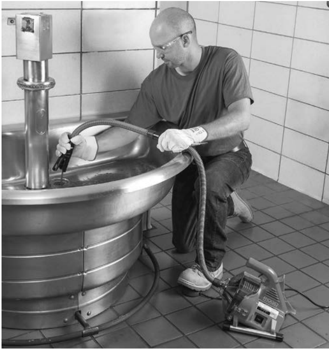
Obrázok 11 – Vyťahovanie špirálového kábla
