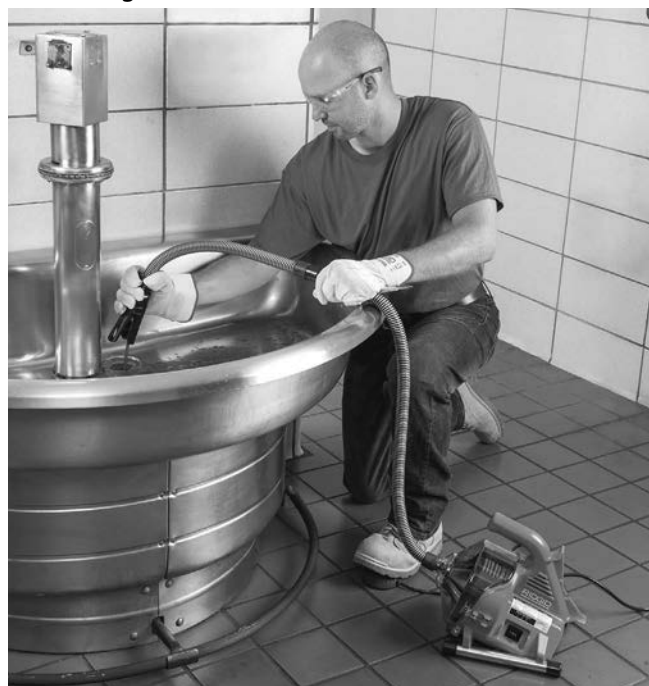
Abbildung 11 – Zurückziehen der Spirale
