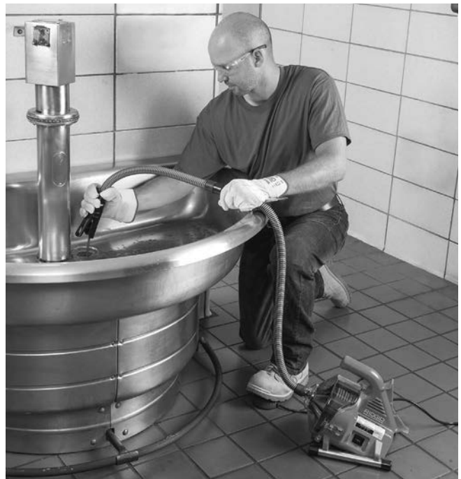
11. ábra – A kábel kihúzása
