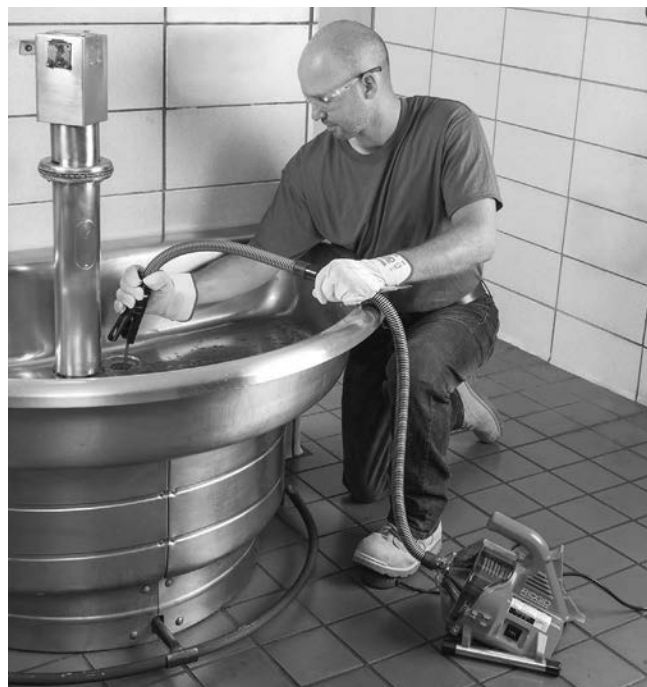
Obrázek 11 – Vytažení kabelu
