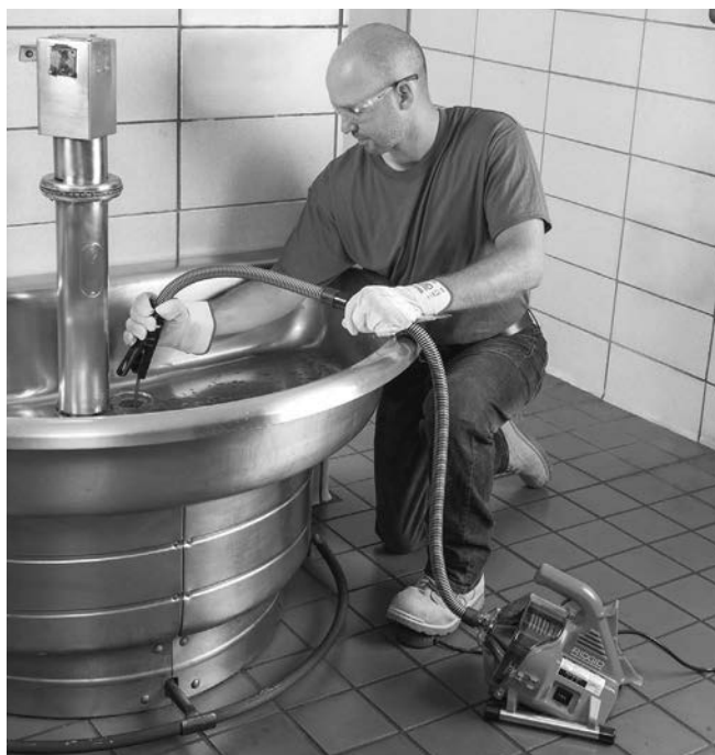
Figura 11 – Recupero del Cavo
