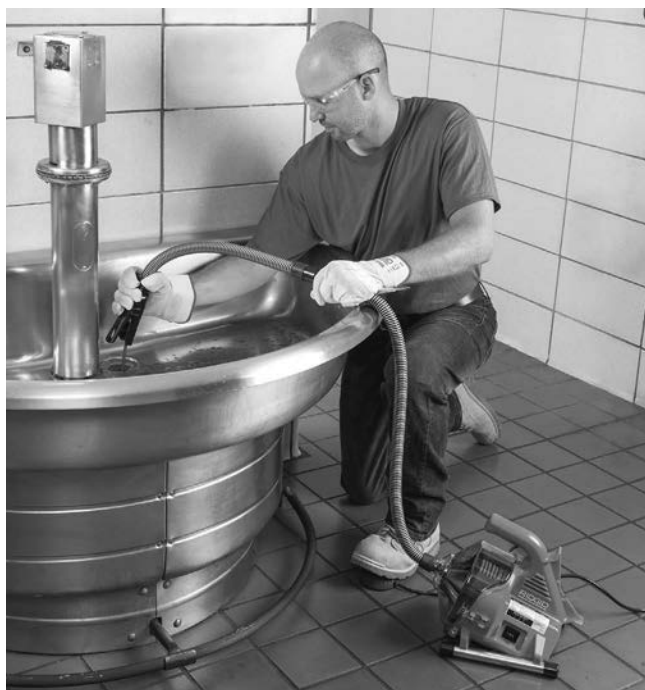
Slika 11 - Povlačenje sajle
