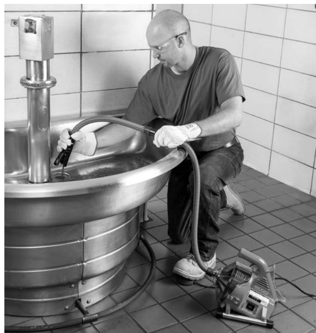
Figure 11 – Récupération du câble
