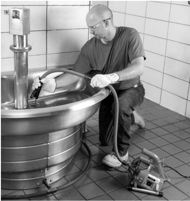
Figura 11 – Recuperación del cable
