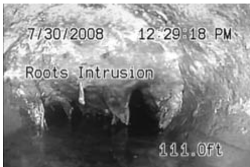
Figur 25 – Visning med bildetekst, tid og avstand (avstand målt fra systemets nullpunkt)
