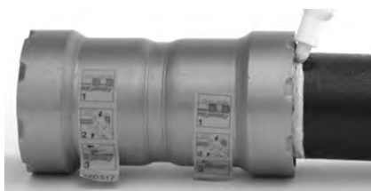
Figure 7 – Repérage du tuyau après son insertion
