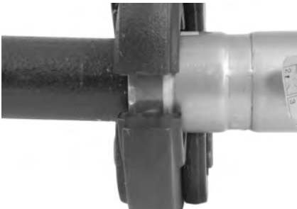
Figura 9 – Mordazas MegaPress colocadas en ángulo recto en relación con el acoplador y el tubo
