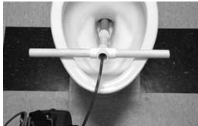
Figura 24 – Empleo de un tubo-guía de PVC
