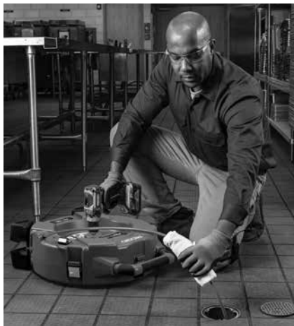
Figura 13 – Ungerea manșonului cablului
