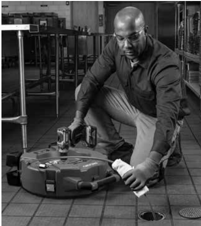
Abbildung 13 – Auftragen von Schmiermittel auf die Spiraleummantelung
