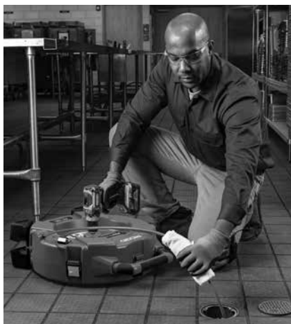
Figur 13 - Påføring av smøremiddel på kabelmantelen
