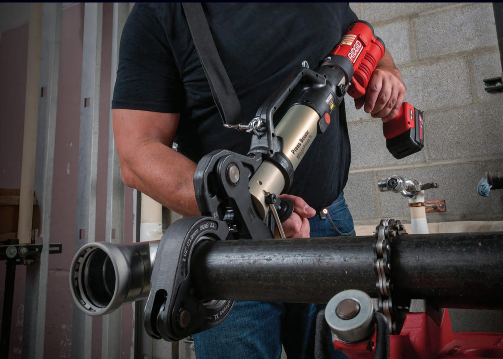
**Les mâchoires et bagues MegaPress® servent au sertissage des raccords Viega® MegaPress® Ø ½" à 4" sur les tuyaux acier type 5-40 du commerce.**
