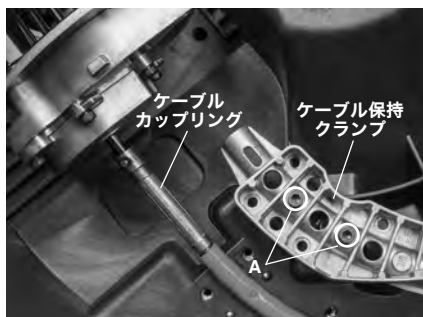
図 19 - ケーブルの設置
