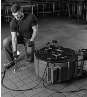
図 11 - ケーブルシースへの潤滑油の塗布
