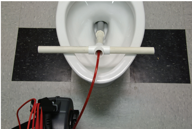
Afbeelding 22 – Een PVC-geleidebuis gebruiken
