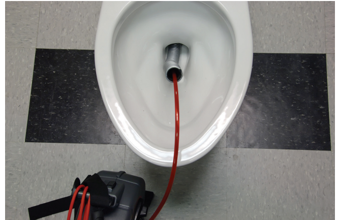
Afbeelding 23 – De flexibele geleidebuis gebruiken
