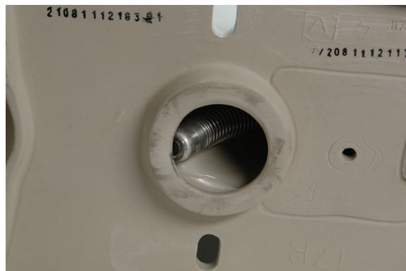
Afbeelding 16 – Camerakop geblokkeerd in bocht
