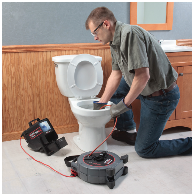
Afbeelding 13 – Een inspectie uitvoeren
