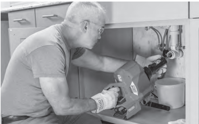
Figura 13 – Alimentación del cable con la unidad AUTOFEED
