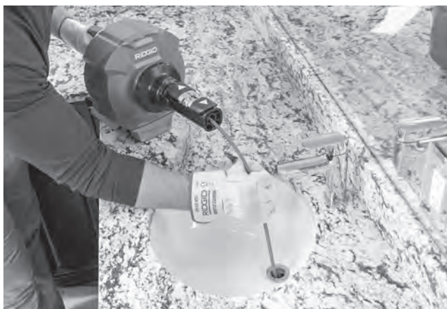
Figure 14 – Avancement manuel du câble
