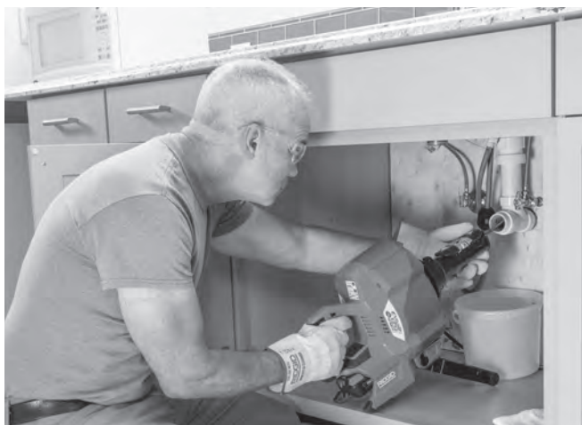
Abbildung 13 – Vorwärtsschieben der Spirale mit AUTOFEED
