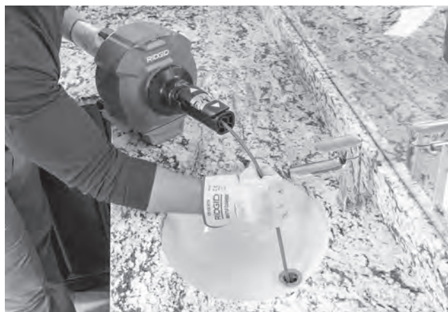
Abbildung 14 – Manuelles Vorschieben der Spirale
