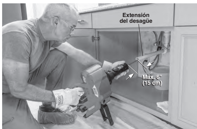
Figura 6 – Ejemplo de la extensión del desagüe para que quede a menos de 6 pulgadas (15 cm) de la unidad AUTOFEED
