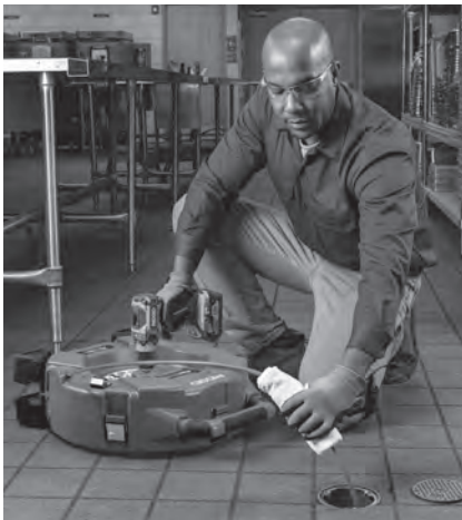
Abbildung 13 – Auftragen von Schmiermittel auf die Spiraleummantelung
