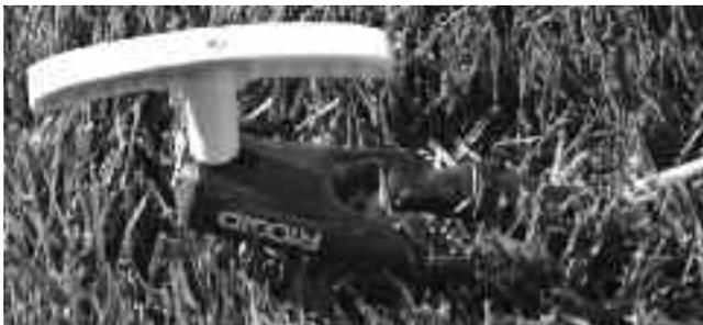
Abbildung 7 – Anschluss des Kabels an einen Erdungsstab
