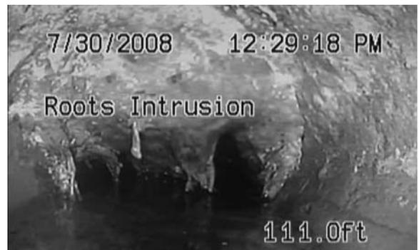
Figure 30 – Écran d'affichage avec texte rapporté et indiquant l'heure et la distance parcourue depuis le point zéro du système.
