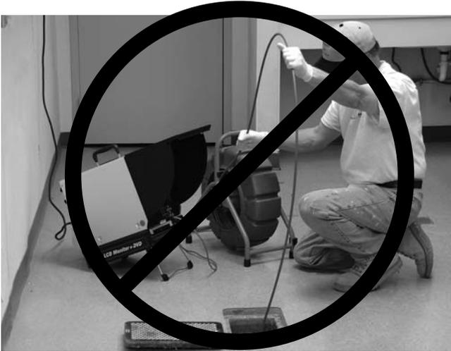
Figure 27 – Mauvaise technique de poussée du câble
