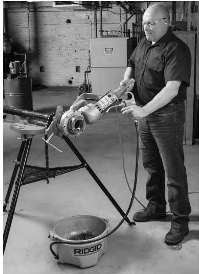
Figure 9 – Filetage des tuyaux
