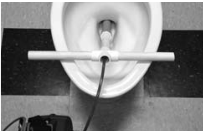
Figure 24 – Positionnement d'un tube de guidage en PVC
