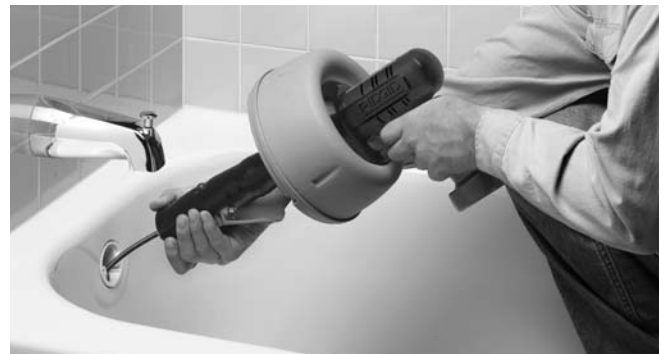
Figure 8 – Tenez le dégorgeoir à un maximum de 6 po du point d'entrée
