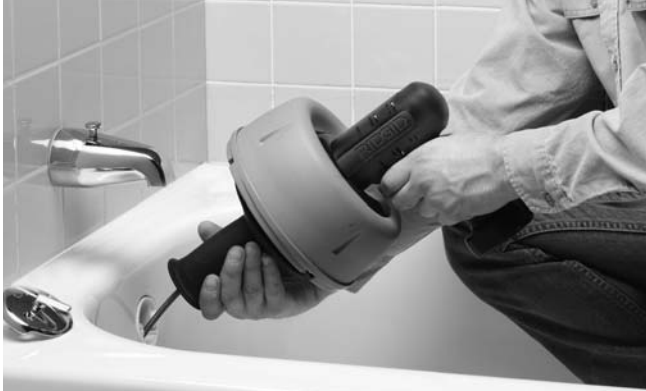
Figure 6 – Poussez le câble le long de l'évacuation
