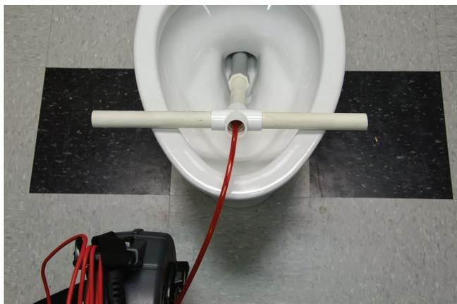
Figure 22 – Utiliser un tuyau-guide en PVC
