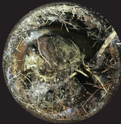
สิ่งอุดตันกึ่งแข็ง รากฝอย รากแก้วของต้นไม้
