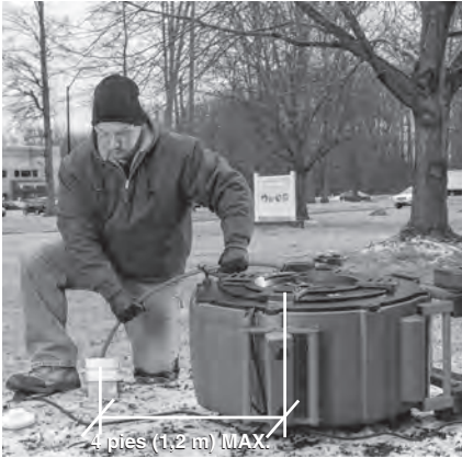
Figura 10 – El operario en posición correcta para trabajar
