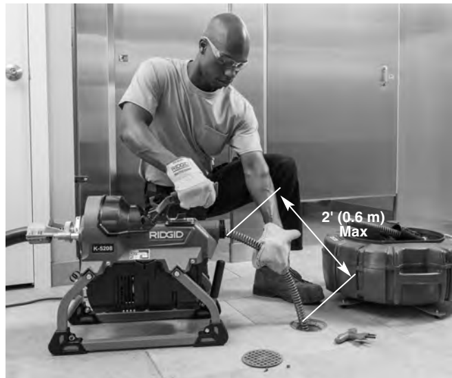
Figura 9 – El operario en posición de trabajo
