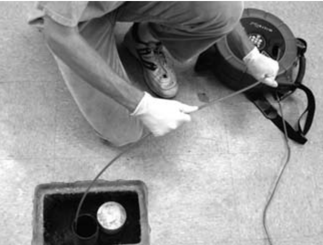
Şekil 28 – Kabloyu Tambura İtmek İçin Düzgün Teknik
