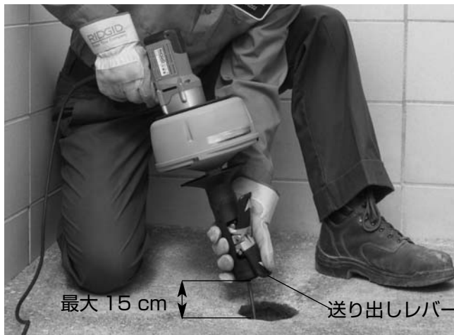
図 10—オートフィードによるケーブル挿入
