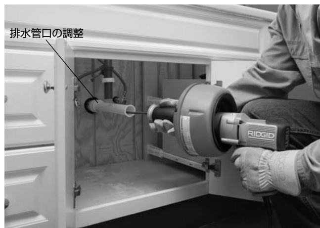
図6—ケーブル端から 15cm 以内になるよう延長した例
