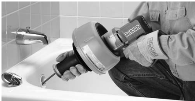
図 9—ケーブルを排水管内に挿入
