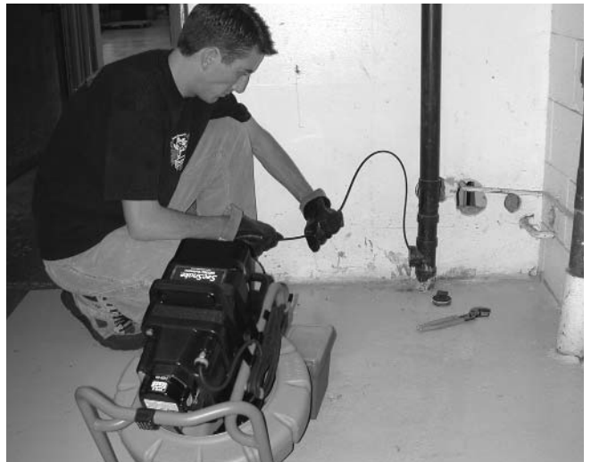
Figure 16 – Manière incorrecte de tenir le câble d'avancement
