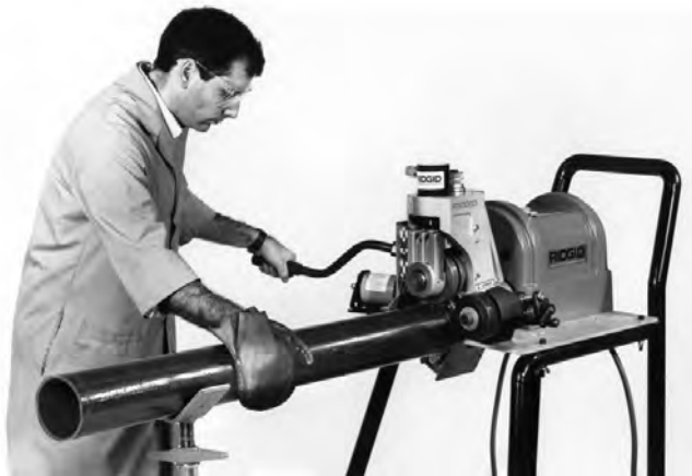
Figura 9 – Ranurado de un tubo mientras el operario ejerce hacia él una leve presión sobre el tubo con su mano derecha
