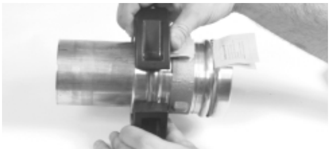
Figura 8 – Instalación del aro sobre el acoplamiento
