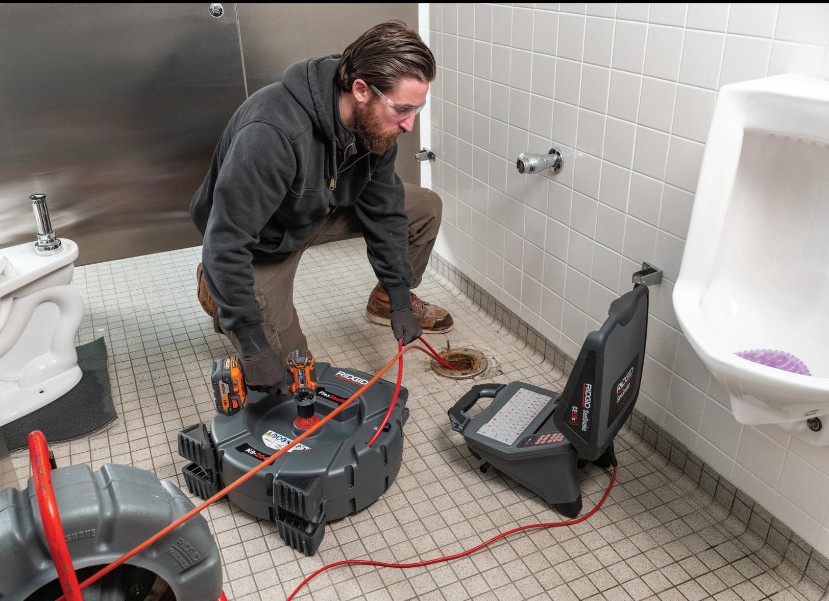
Las nuevas máquinas FlexShaft de RIDGID son livianas, compactas y sumamente eficientes. Limpian todo el interior de tuberías de desagüe de 1¼" a 4" de diámetro y de una longitud de hasta 70 pies (21 metros). Las máquinas FlexShaft también pueden funcionar cuando se ha colocado una cámara de inspección en la tubería, lo cual le permite al operario ir viendo lo que está limpiando. Ningún otro especialista en atascos blandos es capaz de hacer esto.
