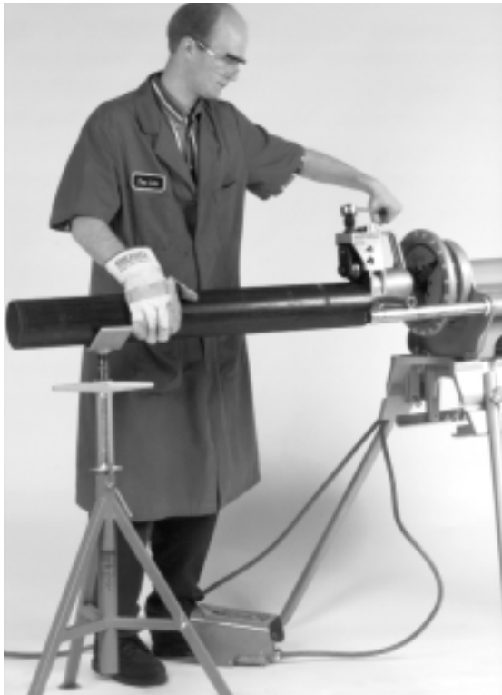
Figure 9 – Rabattement du tuyau avec le moteur d'entraînement en marche arrière
