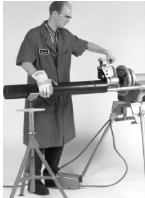
Figura 9 – El operador ejerce presión hacia él sobre el tubo, mientras el accionamiento autopropulsado se encuentra en la modalidad de REVERSA
