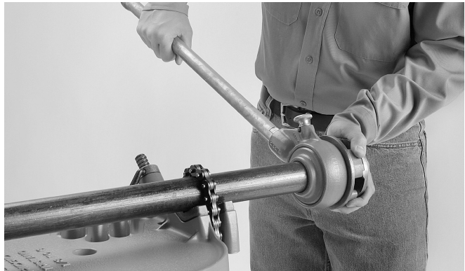
Figure 3 – Montage de la fileteuse sur le tuyau
